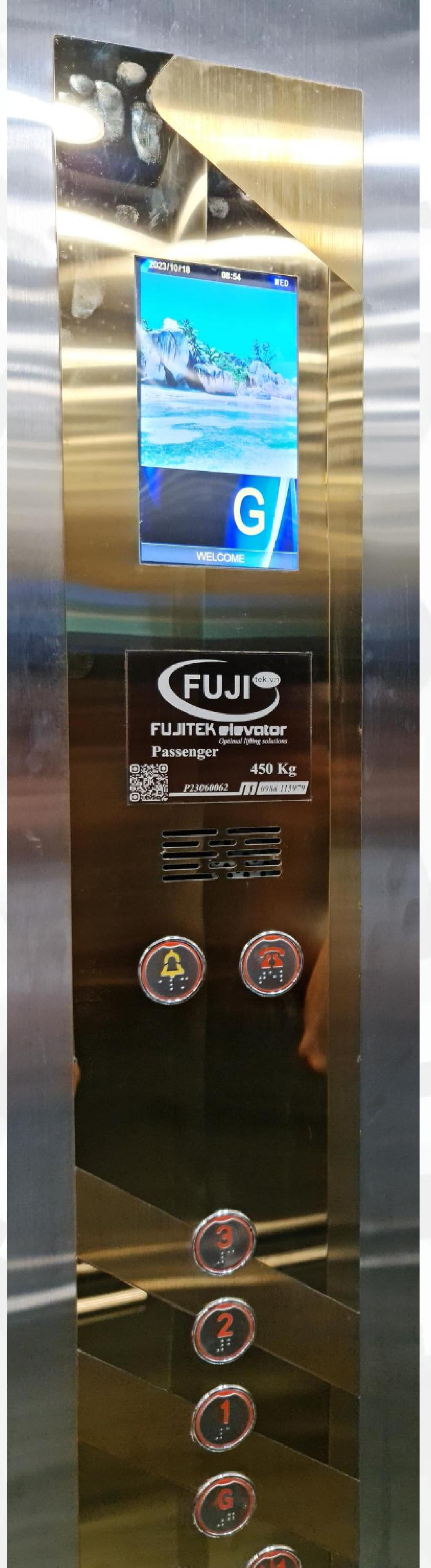
**Bảng điều khiển cabin thang máy** là hệ thống các nút điều khiển tích hợp, điện thoại
